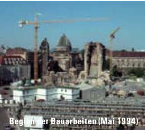
Beginn der Bauarbeiten (Mai 1994)
